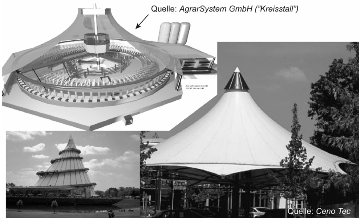
Abbildung 6: Schematische Darstellung von Gebäuden mit kegelförmiger Dachkonstruktion – hier ausgeführt als Hochpunktmembranen aus textilen Kunststoffmaterialien (Quellen: AgrarSystem GmbH und CENO-TEC); Beispiele: Kreisstall, Autopavillon, Messegebäude auf der IGA 2000
